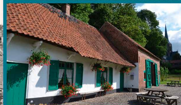
Restauratie Huisje Mostinckx
